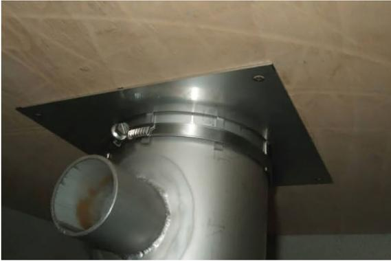
9. Оттяните смешивающую трубу назад до упора. Протолкните хомут и фланец вместе до стены.
