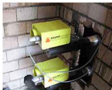
5 контактный разъем с патрубком для кабеля
