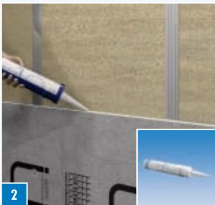
**2** Конструкционные панели ELEMENT-VK склеиваются между собой с помощью COL-MK. При этом клей наносится непрерывной полосой на кромки панелей.
