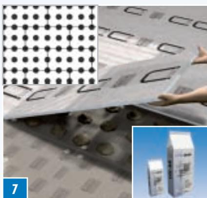
**Укладка на пол (Укладка на деревянный пол)** – Для панелей, начиная с EL-VK 30, возможно также нанесение шпелков клея. Расстояние между шпелками клея должно составлять приблизительно 20 см. Подготовка основания осуществляется в соответствии с пунктом 6.
