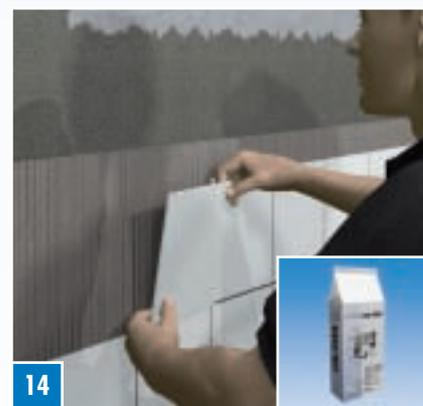
**Укладка керамической плитки с применением COL-FLEX.** Для пола можно дополнительно использовать COL-FBK. Его наносят на всю поверхность зубчатым шпателем.
