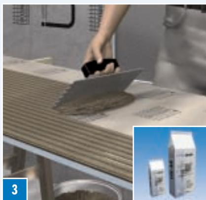
**Укладка на стены** – Если основа ровная, можно также нанести клей COL-AK зубчатым шпателем на всю поверхность.
