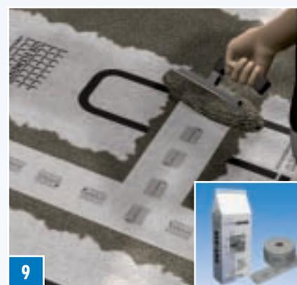
**Переходы (при укладке на пол)** – Уплотнение стыков осуществляется гидроизоляционной лентой DRY-DBV и DRY-ASK. DRY-ASK наносят кистью или шпателем. При этом гидроизоляционная лента приклеивается с помощью DRY-ASK. На втором этапе составом DRY-ASK покрывается стык.
