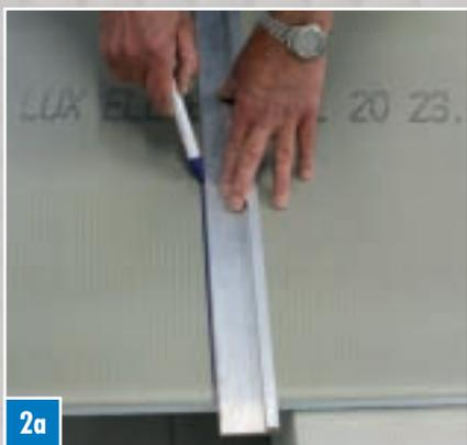
Перед резкой следует начертить линию разреза с помощью карандаша и линейки
