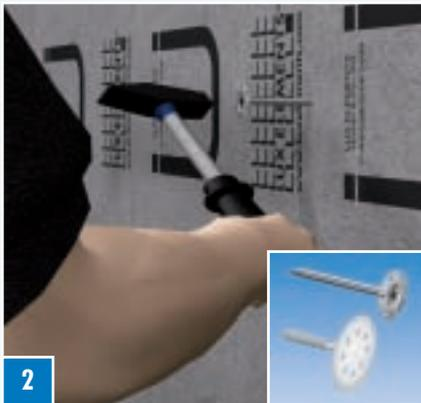
**2** Дополнительно вбить дюбели FIX-FID или FIX-KSD. При вбивании дюбелей обратить внимание на трубы водопроводов и электропроводку! Перед нанесением клея необходимо отверткой для винтов с крестообразным шлицом предварительно проколоть отверстия под дюбели.
