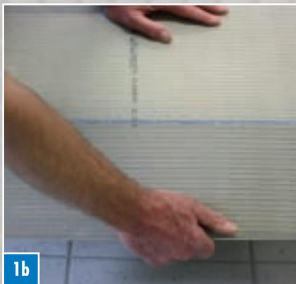
Для панелей меньшей толщины (4 мм) достаточно сделать единственный разрез, чтобы панель разделилась. Работая с панелями большей толщины (от 6 до 20 мм), их нужно дополнительно согнуть по линии разреза.
