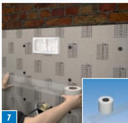
**7** Все стыки элементов необходимо армировать стекловолоконной армирующей лентой ARM-100 SK. Затем стыки элементов выравниваются с помощью COL-AK.
