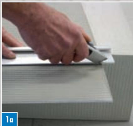
Проведя резак вдоль приложенной к поверхности панели линейки, сделать на верхней поверхности конструкционной панели ELEMENT сквозной разрез.
