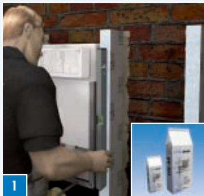
**1** Вырезанный необходимого размера ELEMENT-EL 50 приклеивается к стене с помощью COL-AK так, чтобы можно было произвести горизонтальное и вертикальное выравнивание.
