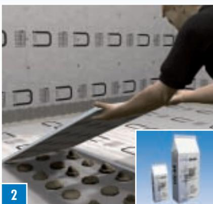
**2** В случае использования панелей ELEMENT-VK 30 или панелей большей толщины нанести на пол шлепки клея COL-AM. Расстояние между шлепками клея должно составлять приблизительно 20 см. Панели плотно уложить встык на клей и подогнать с помощью постукивания. Неровности можно разгладить. Для панелей меньшей толщины клей наносится на всю поверхность (см. рис. 5 на стр. 36).
