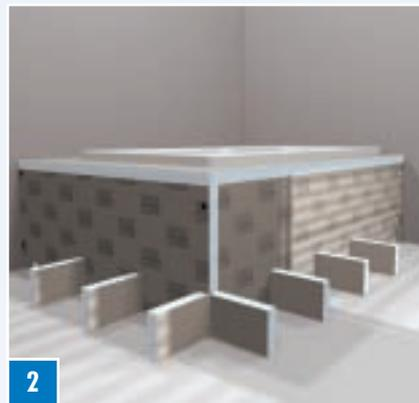
**2** Из остатков материала вырезать одинаковые по размеру подставки, которые будут использоваться в качестве основы для ступенек ( $\geq$  EL-30). С помощью COL-MK приклеить их с одинаковым интервалом (приблизительно 30 см) к полу и внешней стенке ванны.
