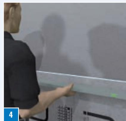
**Укладка на стены** – Панели ELEMENT-VK рекомендуется использовать для горизонтальной укладки. Перед укладкой следует нанести метки для выравнивания, где это возможно. После этого с помощью рейки-отвеса и уровня простучать ELEMENT-VK.
