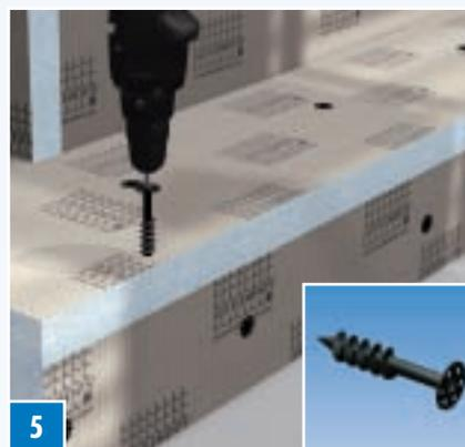
**5** Верхние и боковые части ступеней дополнительно фиксируются с помощью FIX-SD 80. **ПРИМЕЧАНИЕ:** С помощью отвертки для винтов с крестообразным шлицем предварительно проколоть отверстия под дюбели.
