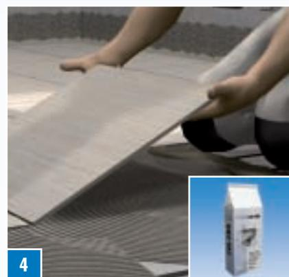
**4** Плитка укладывается без пустот с помощью клея для плитки COL-FBK или COL-FLEX.
