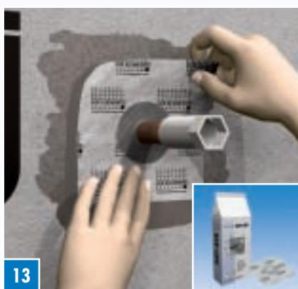
**Сквозные отверстия в стенах** – Соединение со сквозными отверстиями в стенах осуществляется с использованием манжеты с расширяющимся участком, которая приклеивается с помощью DRY-ASK способом, описанным в пункте 9.
