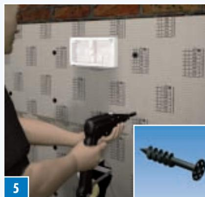
**5** Дополнительная фиксация осуществляется специальными фиксирующими саморезами FIX-SD 80.
