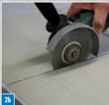
Подготовить к работе угловую шлифовальную машину (сегментированный алмазный полировальный диск) и разрезать конструкционную панель ELEMENT по линии разреза (вести очень легко, не прилагая усилий).
