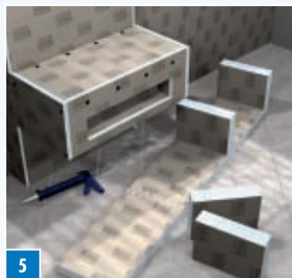
5 Боковина для полки из ELEMENT-EL 60 кладется на пол, и отмечается край бордюра. Бордюры из ELEMENT-EL 100 в надлежащем порядке выпиливаются и приклеиваются с помощью COL-MK к боковине полки.
