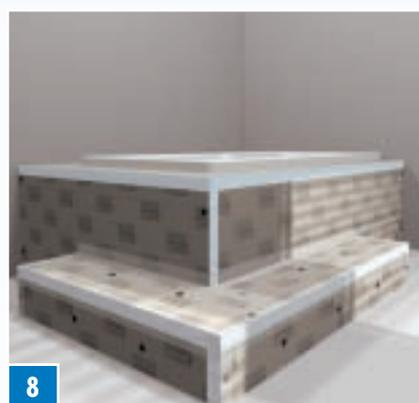
**8** ... и зашпательвать COL-AK. Теперь поверхность готова к укладке керамической плитки. Дальнейшие требования (например, герметизация стен во влажных помещениях) учитываются в соответствии с Государственными стандартами.
