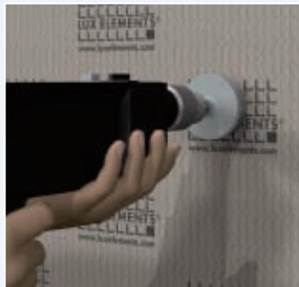
Отверстие в ELEMENT просверливается кольцевым сверлом.
