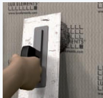
Несущий материал из жестковспененного полистирола вырезается резакком, жестковспененный полистирол выскабливается наружу, заполняется COL-AK в котором укрепляются крепежные элементы.
