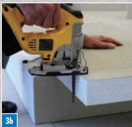
Непосредственно перед резкой следует начертить линию разреза с помощью карандаша и линейки. Затем разрезать конструкционную панель ELEMENT ножовочной пилой по линии (не прилагая усилий).
