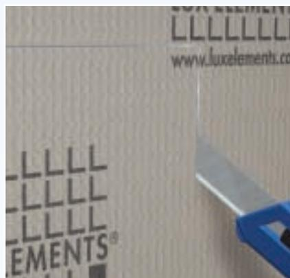
Параллельно надрезать жестковспененный несущий элемент. В зависимости от размеров и длины жестковспененного несущего элемента при изготовлении прорезей можно использовать резак или угловую шлифовальную машину с алмазным диском (болгарку).
