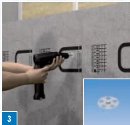
**3** Панели ELEMENT-VK прикручивают с помощью FIX-S 35 и подходящих винтов.
