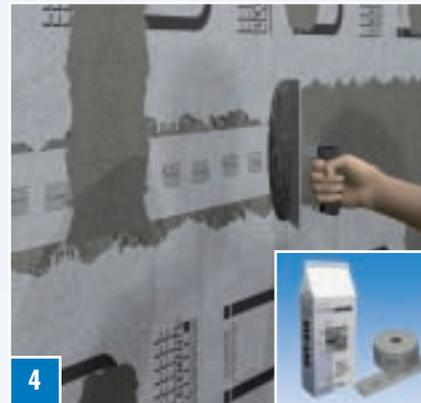
**4** Герметизировать стыки гидроизоляционной лентой DRY-DBV и DRY-ASK. DRY-ASK наносят кистью или шпателем. При этом гидроизоляционная лента приклеивается с помощью DRY-ASK. На втором этапе составом DRY-ASK покрывается стык.
