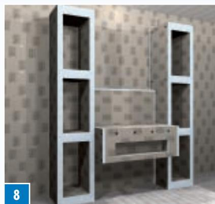
8 Установить готовые полки, склеить их со стеной и нижней конструкцией умывальника. Все стыки элементов и переходы армировать системными компонентами LUX ELEMENTS®-ARM, после чего армированные места зашпатлевать с помощью COL-AK.
