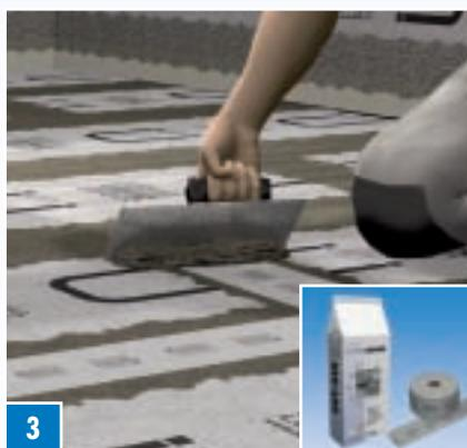
**3** Герметизировать стыки гидроизоляционной лентой DRY-DBV и DRY-ASK. DRY-ASK наносят кистью или шпателем. При этом гидроизоляционная лента приклеивается с помощью DRY-ASK. На втором этапе составом DRY-ASK покрывается стык.
